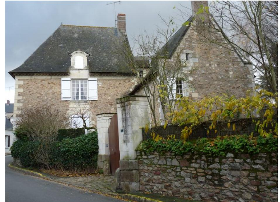
*Dans le centre du bourg de Blaison : habitation dont les murs sont constitués essentiellement de grès remplissant les espaces entre les angles en tuffeau. Un enduit les recouvre plus ou moins. Le mur de clôture est constitué uniquement de blocs de grès.*
