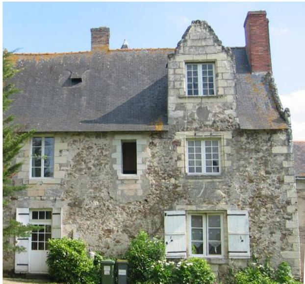
En raison de ces difficultés, les grès ont été essentiellement employés en remplissage dans la construction des habitations ; les arêtes, les détails de l'architecture sont réalisés en tuffeau.
