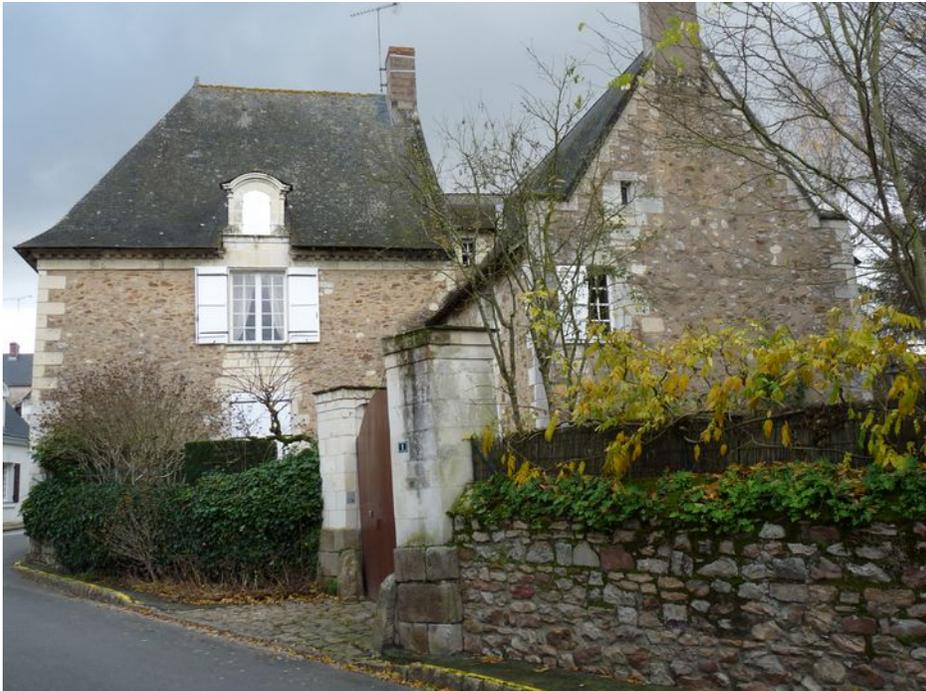
*Dans le centre du bourg de Blaison : habitation dont les murs sont constitués essentiellement de grès remplissant les espaces entre les angles en tuffeau. Un enduit les recouvre plus ou moins. Le mur de clôture est constitué uniquement de blocs de grès.*
